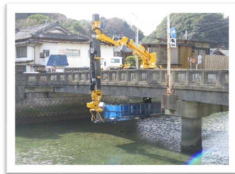
点検状況（千代田橋）
