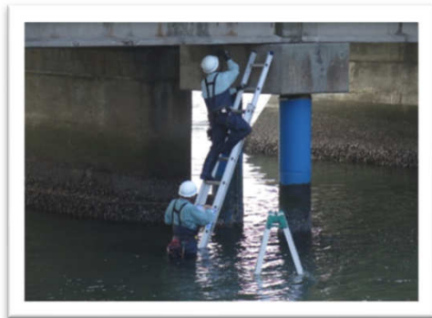
点検状況（第2川之石橋歩道橋）
