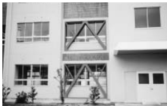
保内中学校耐震工事
