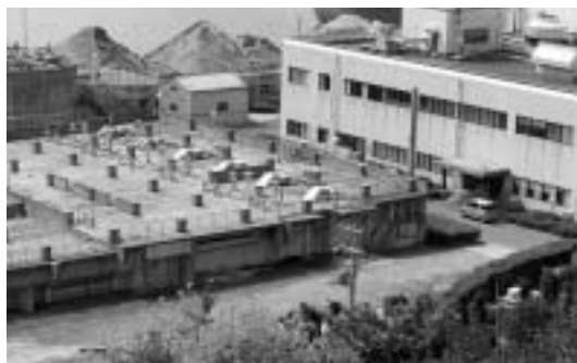
八幡浜浄化センター
