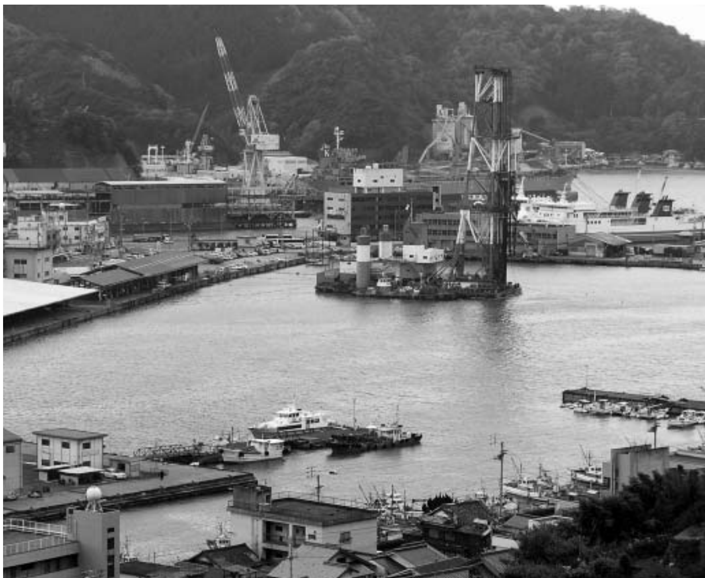
工事が進む八幡浜港
