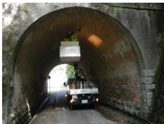
千賀居トンネル
