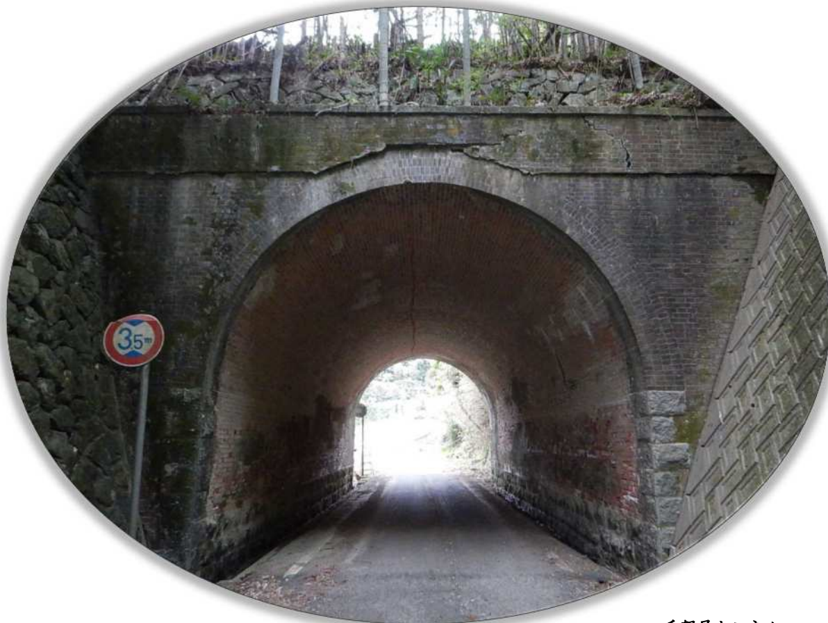
千賀居トンネル
