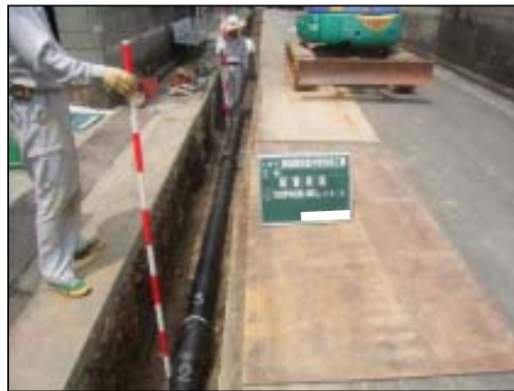
耐震管布設替状況（NS型耐震管）
