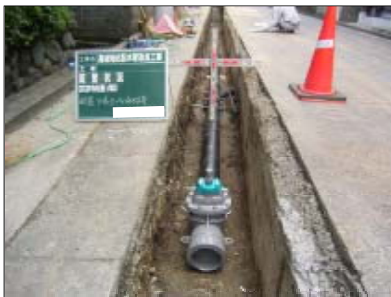
耐震管布設替状況（NS型耐震管）
