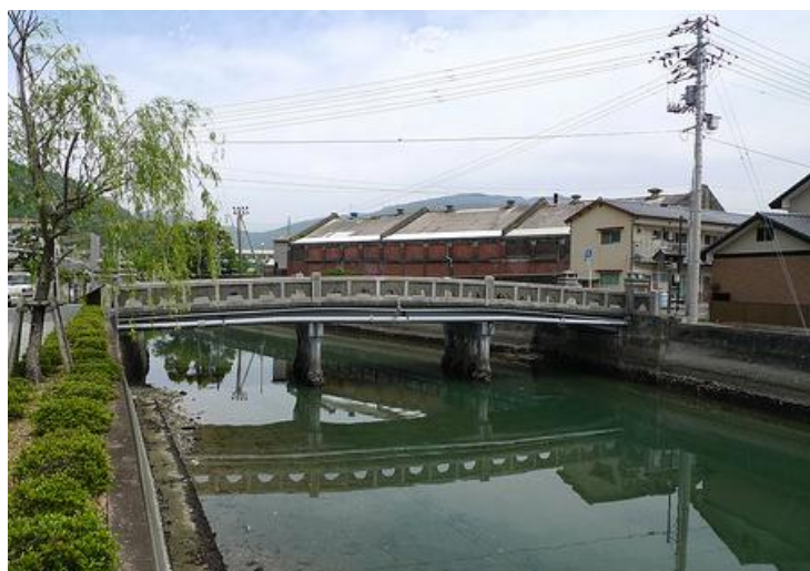
美名瀬橋と赤レンガ倉庫跡 (写真左)
