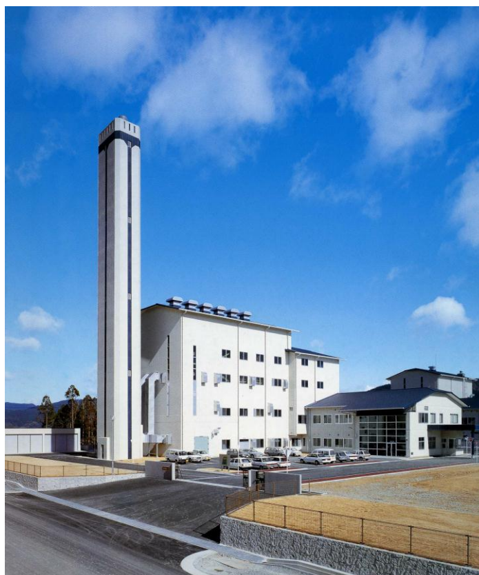
八幡浜南環境センター
