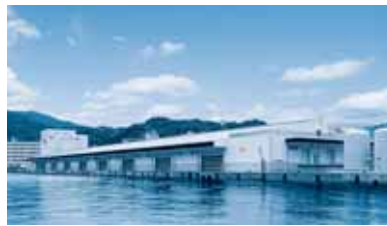
高度衛生管理型荷捌所建設事業
