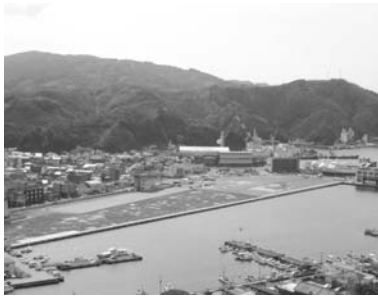
現在の八幡浜港フェリー関連施設予定地
