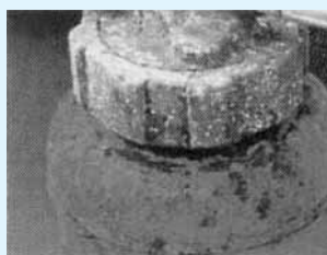
あばた状の腐食
