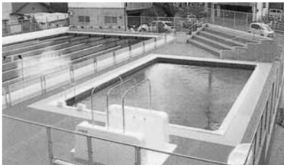
神山小学校プール改築工事
