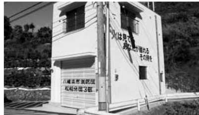
松柏分団3部消防倉庫新築工事
