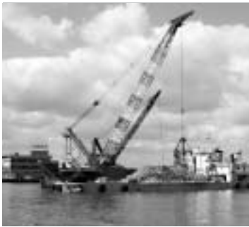
整備の進む八幡浜港
