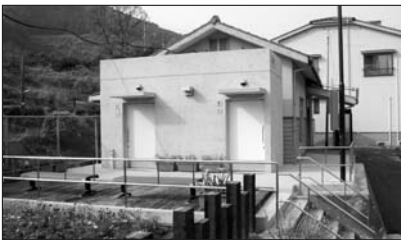
千丈駅前公衆トイレ新築工事
