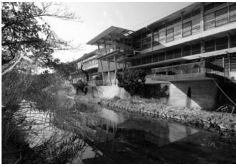
喜木川に張り出したベランダとテラス
