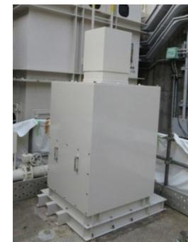
耐震型海水ピット水位計 (電波式)
