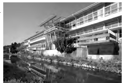
国指定重要文化財 日土小学校中・東校舎
