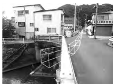
11-0 幹線（千丈川吐口 山越橋下）
