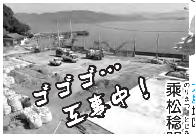
アワビ種苗生産施設の工事現場
