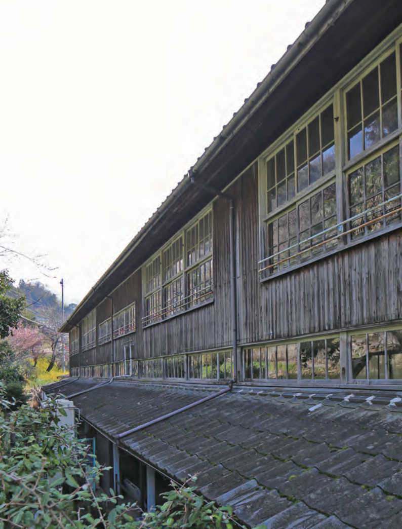
北面廊下外観
