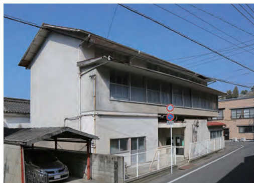
旧図書館 設計:松村正恒 (今後、移築・保存改修を検討する)
