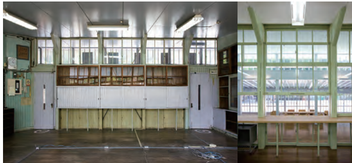
職員室からの運動場の眺め（左：改修前、右：改修後）
