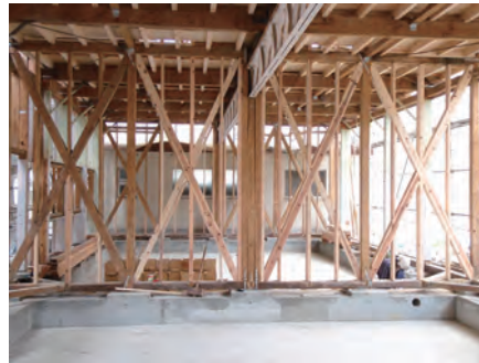
補強工事の様子
