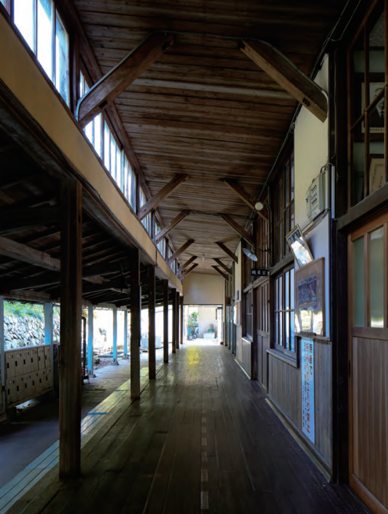
北面廊下 屋根の隙間から教室へ光を取り入れる工夫がよくわかる。
