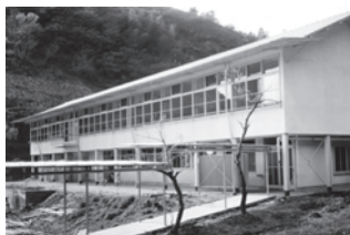
八幡浜総合病院伝染病棟
