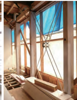
ブレースを二重に補強
