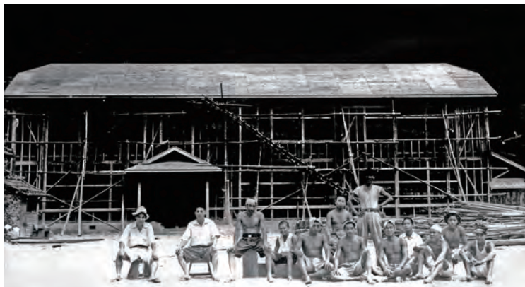
建設中の写真
