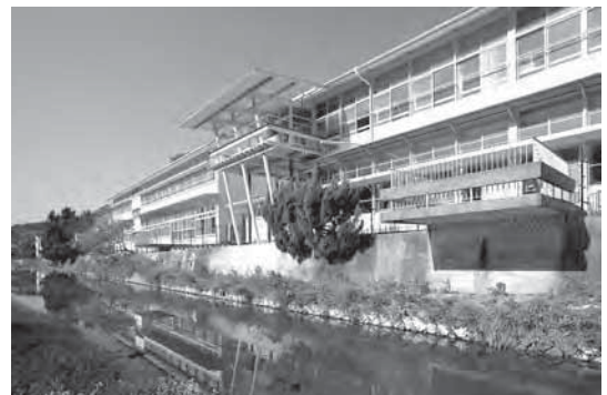
国指定重要文化財 日土小学校中・東校舎
