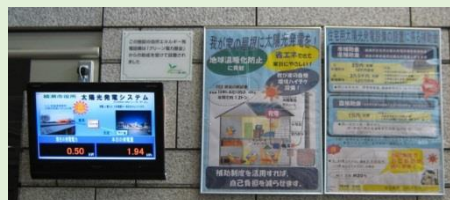
写真3 発電状況表示モニター
