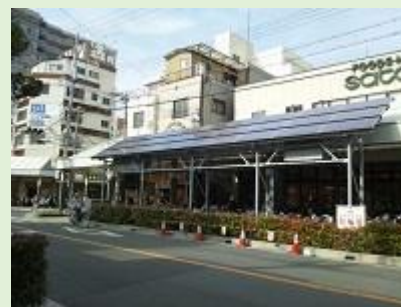
写真 6 吹田市庁舎太陽光発電
