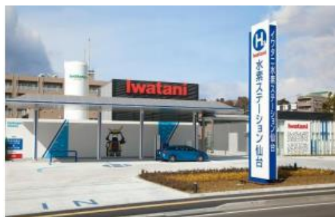
図 1-12 Iwatani水素ステーション 宮城仙台 出典：岩谷産業㈱ホームページ
