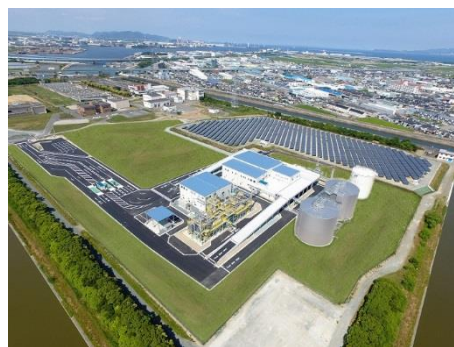
図 1-7 豊橋市バイオマス利活用センター
