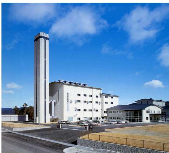
八幡浜南環境センター
