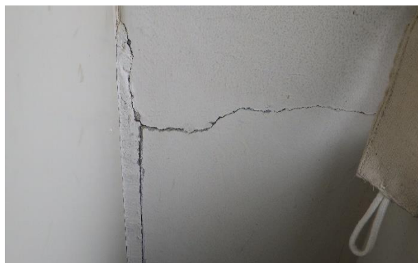
(内部壁ひび割れ 喜須来小学校 本校舎)
