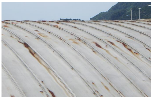
(屋根劣化 愛宕中学校 体育館)
