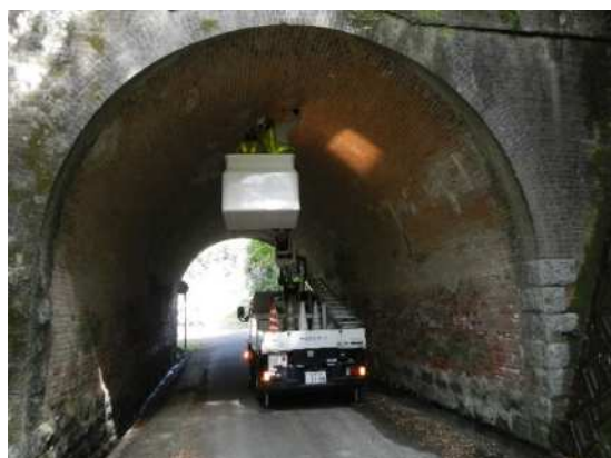
千賀居トンネル
