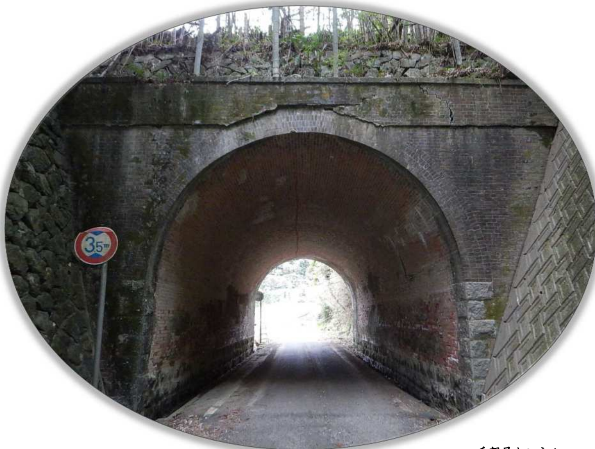
千賀居トンネル
