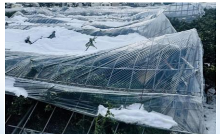
特に被害が大きかった日土地区の倒壊したビニールハウス
