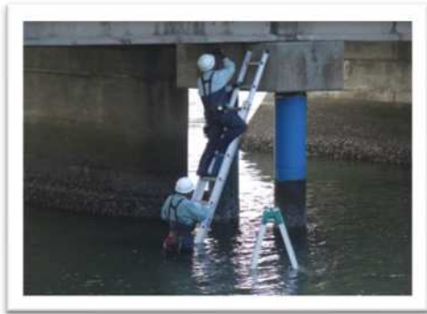
点検状況（第2川之石橋歩道橋）
