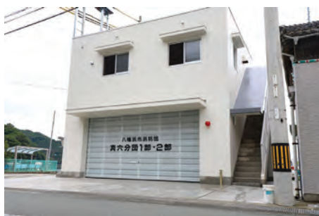
今年6月に建設された真穴分団1・2部詰所
