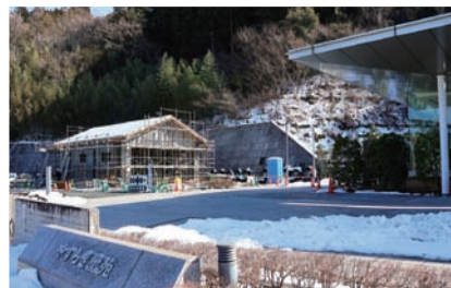
▲やすらぎ聖苑敷地内に建設中
