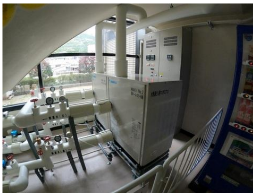
図 12 地中熱ヒートポンプ
