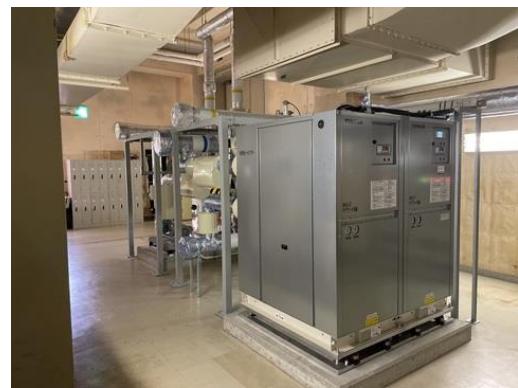
図 12 地中熱ヒートポンプ
