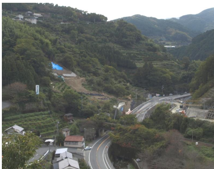
新夜昼トンネル抗口付近
