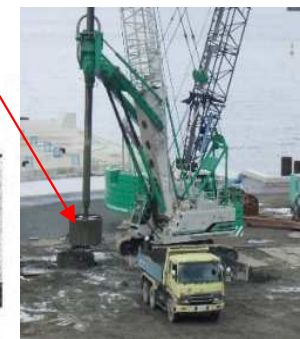
アースドリル工法施工状況
