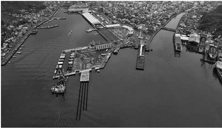
フェリーターミナルビル建設現場
