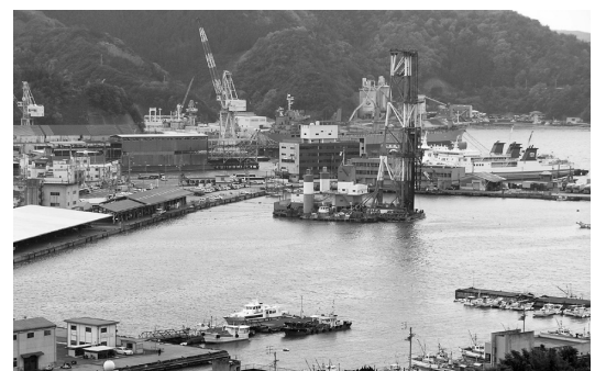
工事が進む八幡浜港
