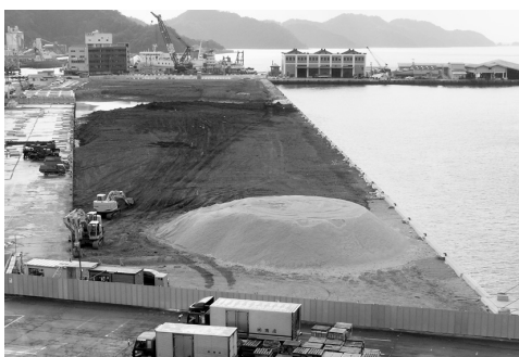
工事が進む八幡浜港
