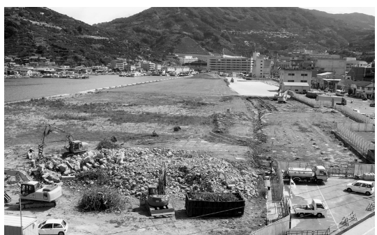
整備が進む八幡浜港
