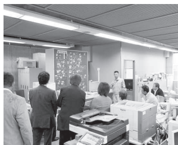
中央監視システム
