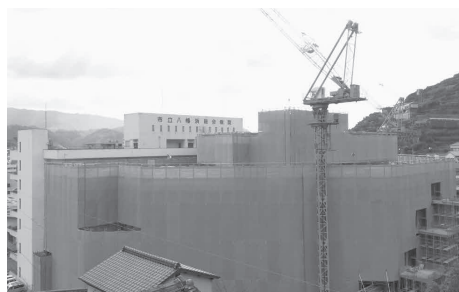
改築中の市立八幡浜総合病院
