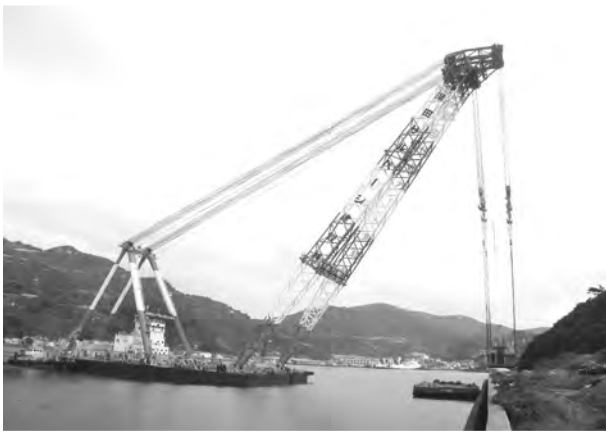
シーロード八幡浜（浮消波堤撤去）
