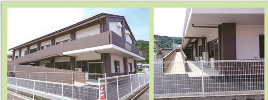
地元からの要望となっていた 2階フロアへの進入が可能な屋外スロープを建物西側に完備 車椅子等で直接2階フロアへ！
