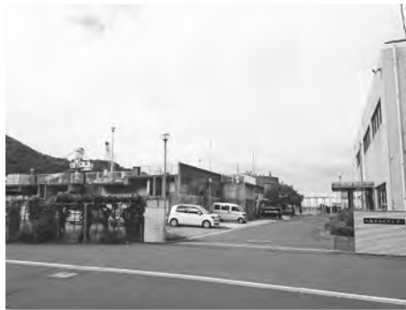
八幡浜市浄化センター
