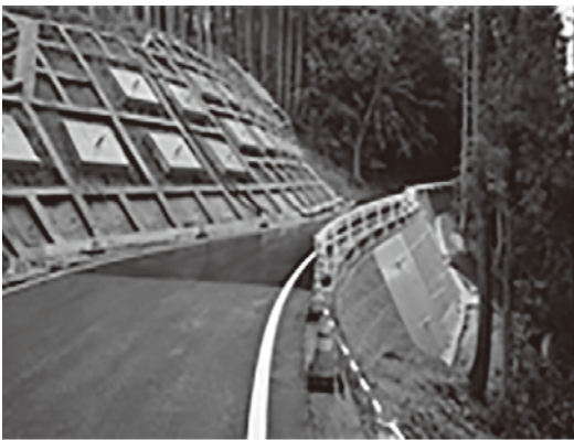
災害による崩落後に復旧された道路や法面
