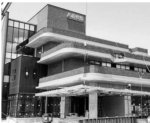
建設中のフェリーターミナルビル
