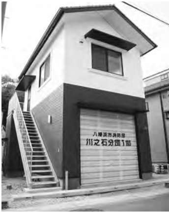
川之石消防団詰所
