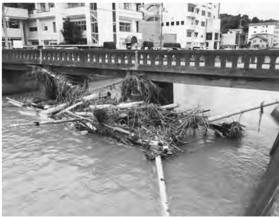
7月豪雨時の浜田橋
