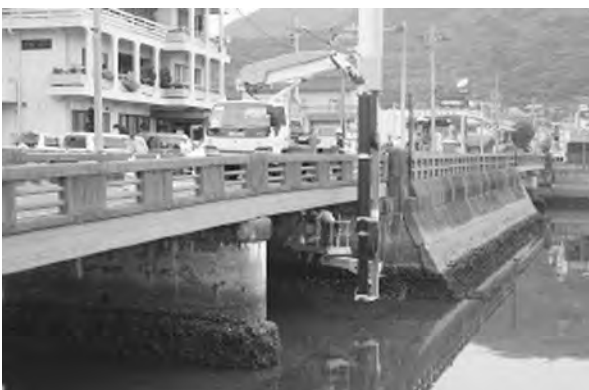
橋梁点検の様子
