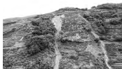
須川奥地区の崩落現場
