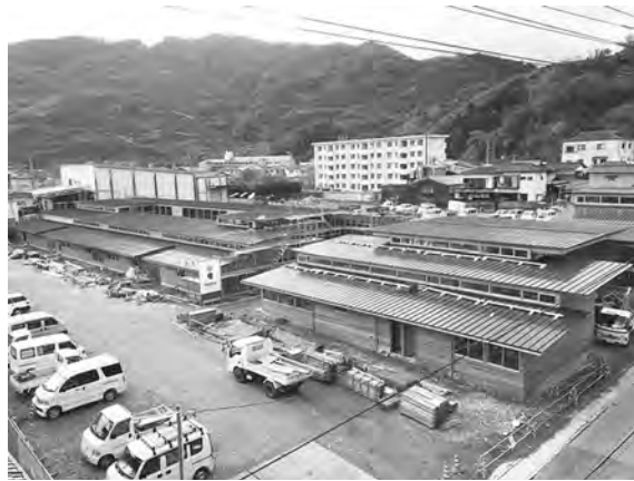
建設が進む保内保育所（仮称）
