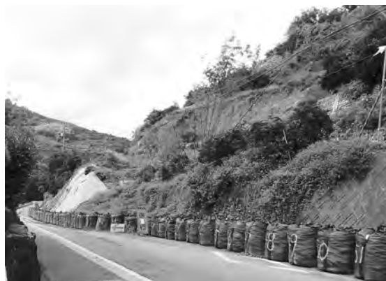
平成30年7月豪雨による斜面崩落 (日土町新堂)
