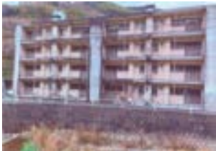
新開町の老朽化している旧県職員官舎
